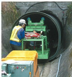
既設トンネル:2r-1860馬蹄形トンネル 内挿管:2r-1650馬蹄形FRPM管 掘工延長:510.27m
