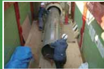
薄肉 FRPM パイプインパイプ工法
