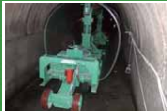
馬蹄形 FRPM パイプトンネル工法
