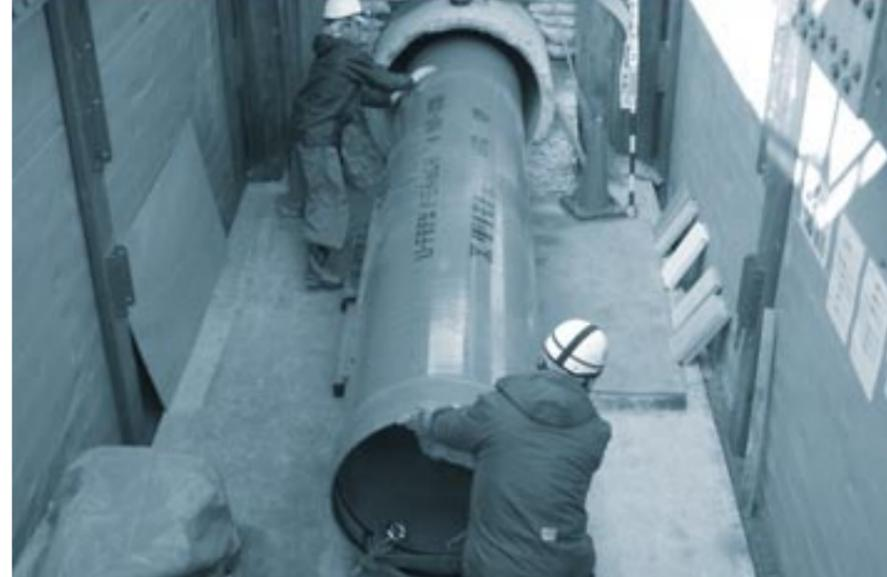
薄肉FRPMパイプインパイプ工法(スリーブイン・ライト工法)は、老朽化した管水路の改修工法です。工事完了後は内面が平滑で、耐食性・耐久性に優れた管渠に更生されます。
